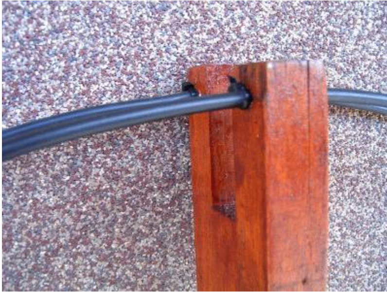
Fig. 3.8 Los bucles se fijan con bridas de plásticos en ambos lados.
