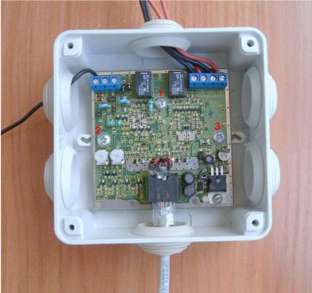
Fig. 2.16 Montaje de la placa del amplificador en la caja.
