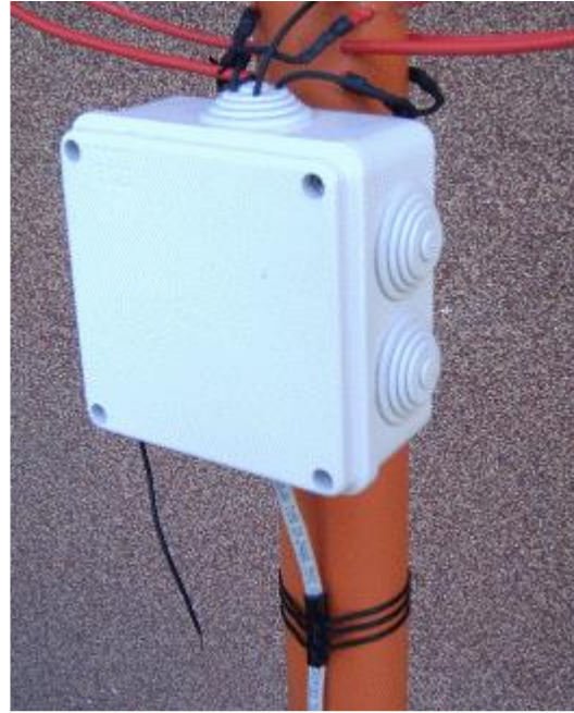
Fig.2.21 Fijación de cable FTP.
