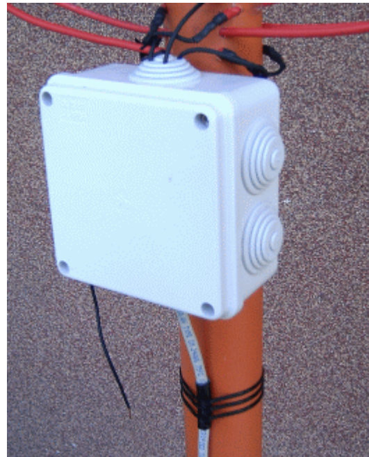
Fig.2.21 Фиксиране на FTP кабела
